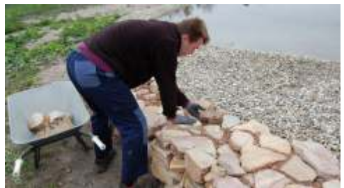
Bau der Trockenmauer am Naturerlebnisteich
