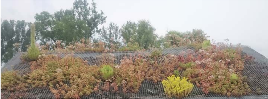
Dachbegrünung mit Fetthenne, Mauerpfeffer und Hauswurz
