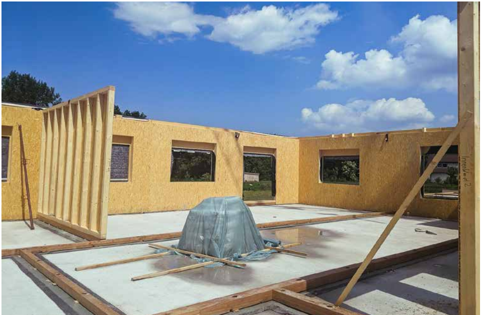
Errichtung der ersten Holzwände im Frühjahr
