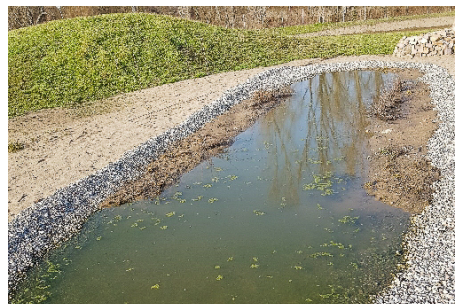
Sumpfbeet beim Bau
