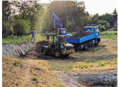
Baggern der Steilwand
