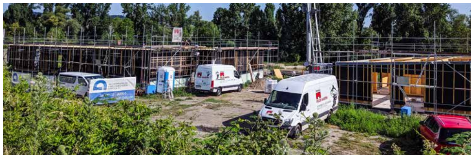
Holzelemente des Zentrums bei Aufbau
